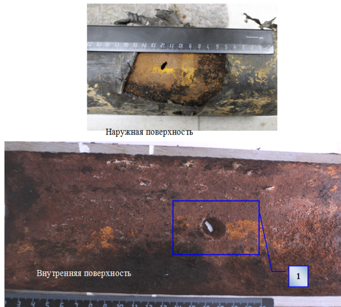
Рис. 5. Вид наружной и внутренней поверхностей исследуемой трубы после эксплуатации в \text{CO}_2 -содержащих средах
