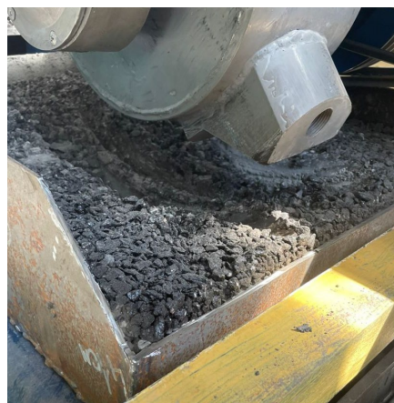
Рис. 3. Подвод барабана к асфальтовому покрытию
