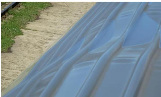
Рис. 1. Характер деформации листов обшивки крыши
